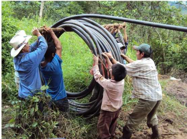
Foto: Aufbau eines autonomen Wassersystems: Verlegung von Rohren
